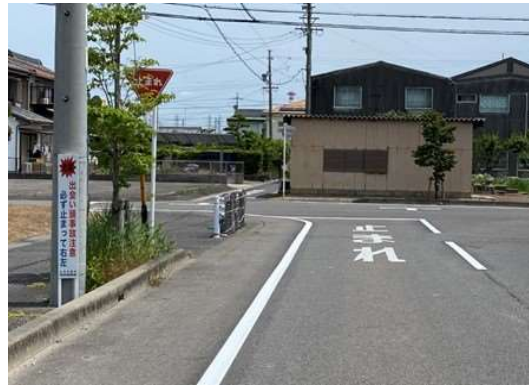
注意喚起の看板設置、白線再塗装
